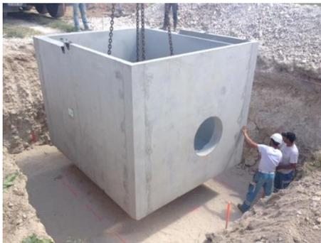
Nous préconisons la réalisation d'un lit de pose en fond de fouille en gravillon 6/10 d'une épaisseur de 20cm (à vérifier selon la nature du site).
